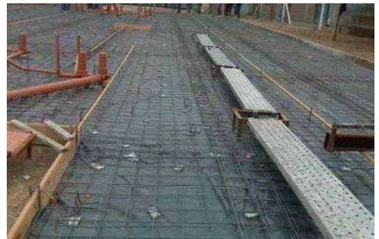
Conjuntamente con esta etapa y siempre asegurando el correcto alineado y verticalidad de los paneles se colocan las mallas de refuerzo y continuidad con las mismas técnicas empleadas para el empalme de mallas.
