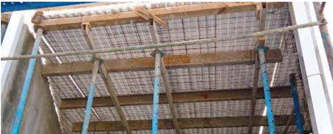
Si bien existe una variedad de técnicas diferentes para el colado del hormigón de losas la más efectiva y recomendable es la de comenzar por la proyección de su superficie inferior en un espesor que apenas alcance para rigidizar los paneles una vez comenzada a fraguar.
