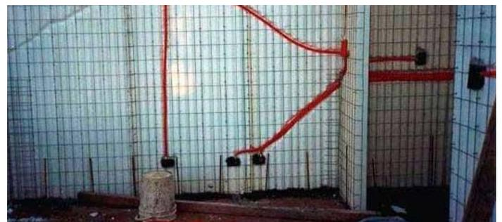
Las tuberías rígidas requieren el corte de la malla en el caso de no disponer el espacio para enfilarlas como las flexibles, y luego de colocadas, se reconstituye la continuidad de la malla mediante el empalme de una malla plana adicional que se ata de la manera acostumbrada.
